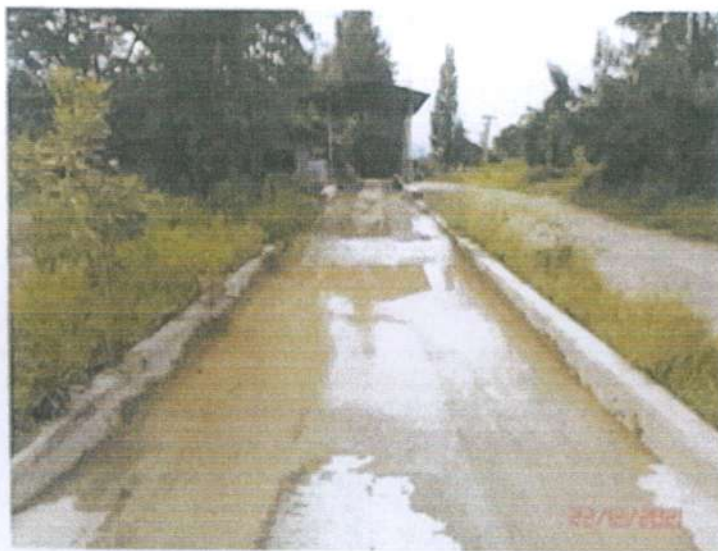
ปล่อยล้างล้อรถก่อนขึ้นตราซัง
